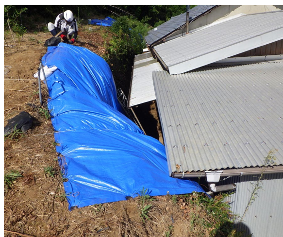
熊本署：人家への山腹崩壊及び応急対策の実施
