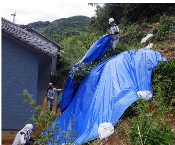
熊本署：人家への山腹崩壊及び応急対策の実施
