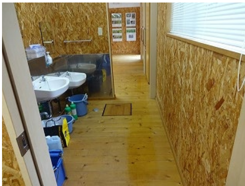
展示館内の清掃状況
