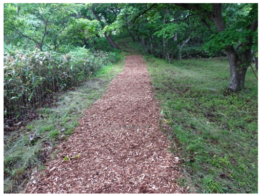
ウッドチップ施工後
