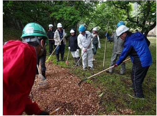
ウッドチップの敷き均し
