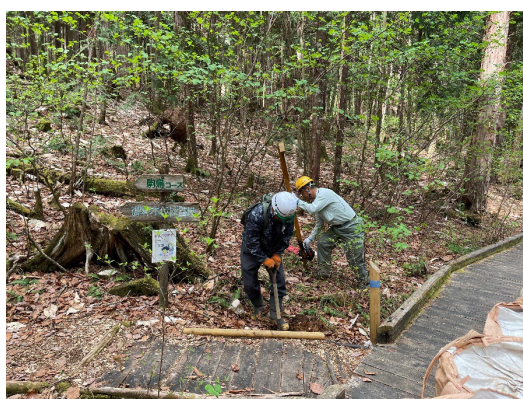
案内板の移設
