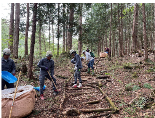
木質チップの敷き均し
