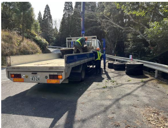
廃タイヤの積込作業の状況
