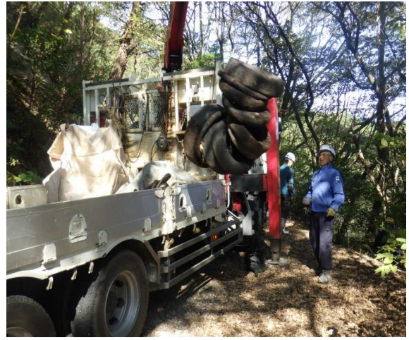
廃タイヤの積込作業
