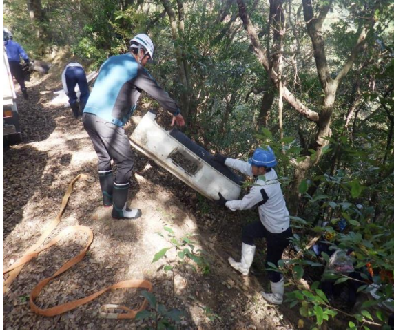
回収作業の状況
