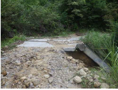
宮崎北部署：路肩決壊及び路面洗堀、崩土の状況
