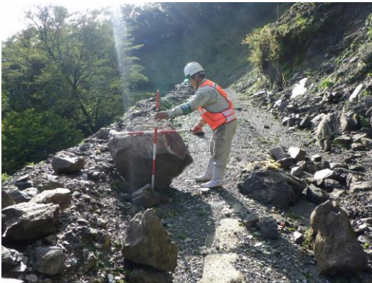
熊本南部署：崩土石調査及び倒木の応急処理の状況
