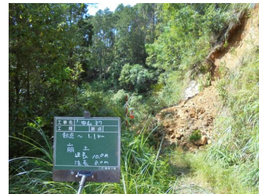
都城支署：路面洗堀の調査状況及び崩土の状況
