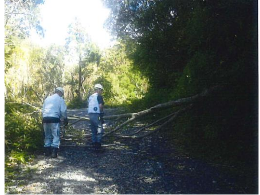
屋久島署：倒木の応急処理の状況
