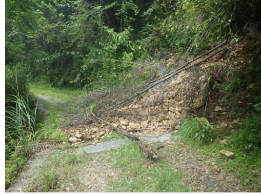
宮崎北部署：路肩決壊及び路面洗堀、崩土の状況
