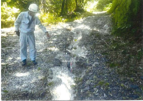
屋久島署：路面洗堀の調査状況
