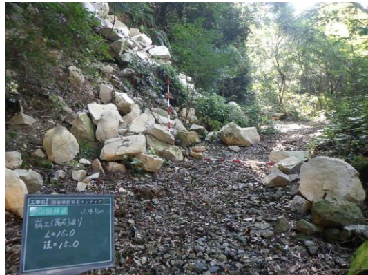
大隅署：路体陥没及び崩土、倒木の状況
