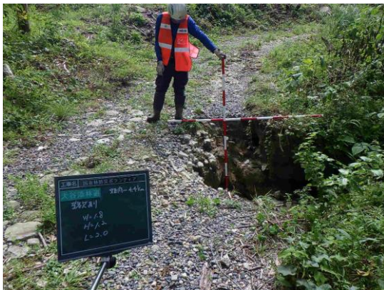
大隅署：路体陥没及び崩土、倒木の状況
