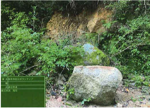
福岡署：林道への崩落石の状況
