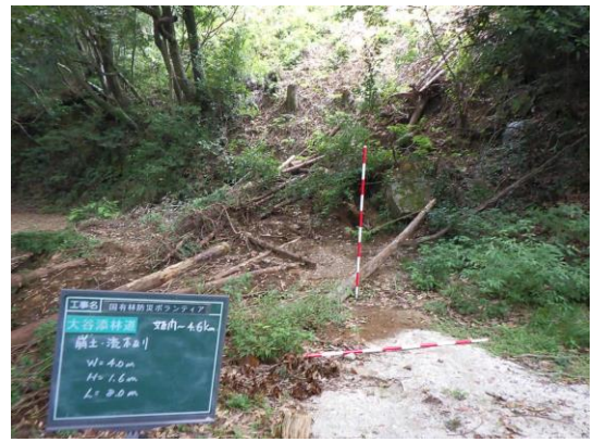
大隅署：路体陥没及び崩土、倒木の状況
