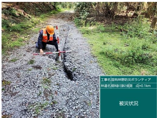
都城支署：路面洗堀の調査状況及び崩土の状況
