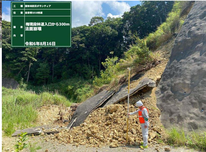
鹿児島署：法面崩壊の調査状況
