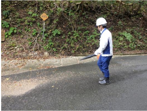
ブローアによる除去作業の様子
