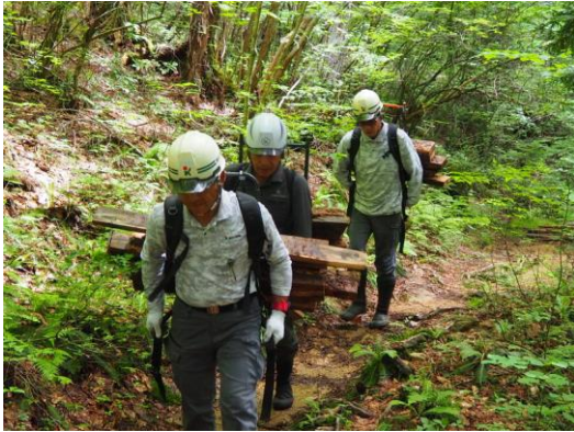
廃材の人力運搬
