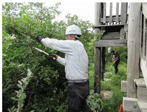
歩道等に繁茂した枝刈払い
