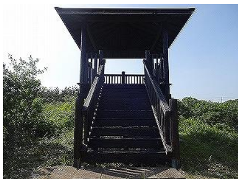
下地塗り完了
