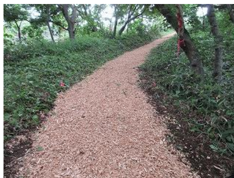
ウッドチップ敷均完成
