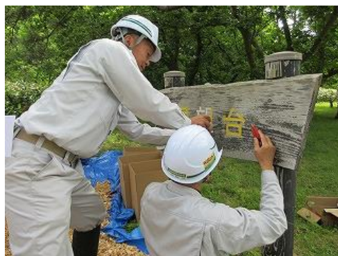
展望台案内看板保護塗料塗布作業
