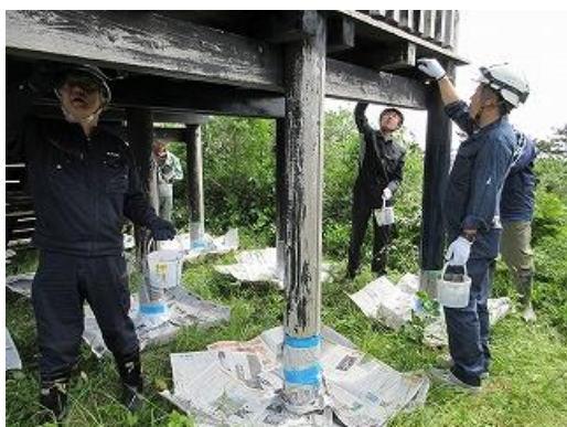
展望台保護塗料塗布作業
