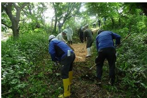
レーキ等により掻き均し整地締固め
