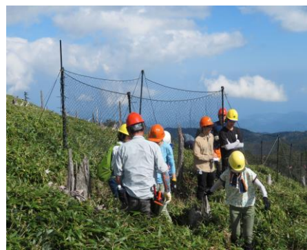
植生保護柵の設置作業
