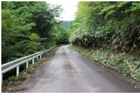
作業後、広々となった道路
