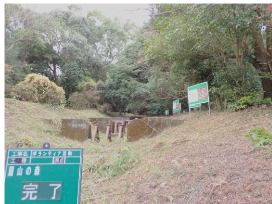
作業後の状況
