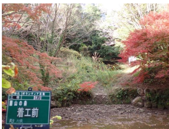
作業前の状況
