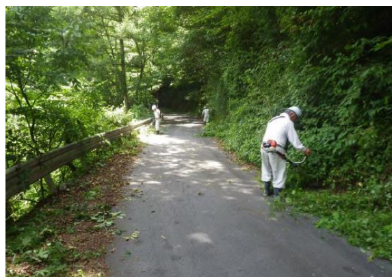
林道沿線の作業の様子
