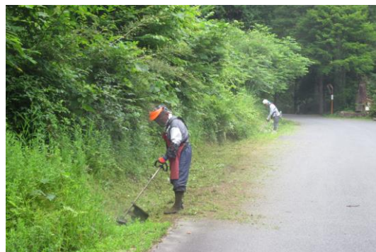
林道沿線の草刈り作業
