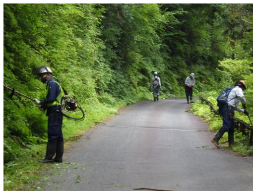
林道沿線の草刈り作業
