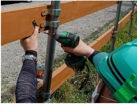
横板金具の取り替え
