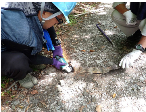
破損した横断溝の切断
