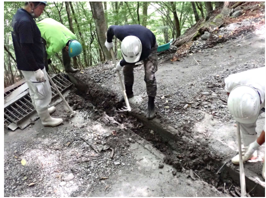
横断溝の掘り上げ
