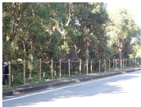
補修された防護柵
