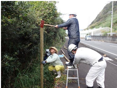
木製防護柵の補修中
