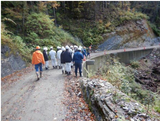
既設構造物の説明を受ける生徒
