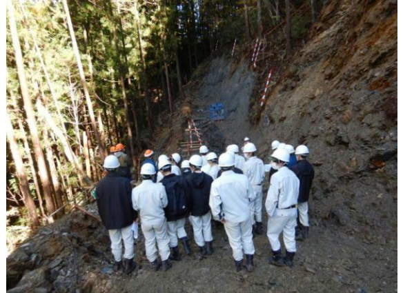
床掘作業を見学
