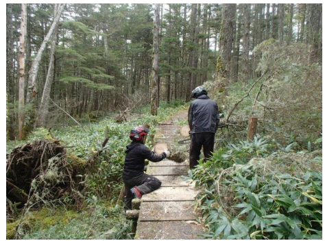
危険木の除去
