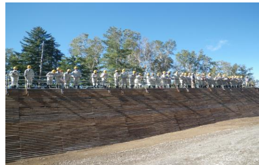
導流堤の天端で構造物の規模を実感
