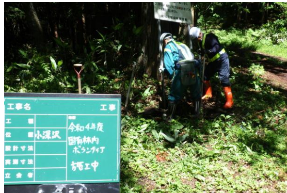
小深沢林道での作業状況
