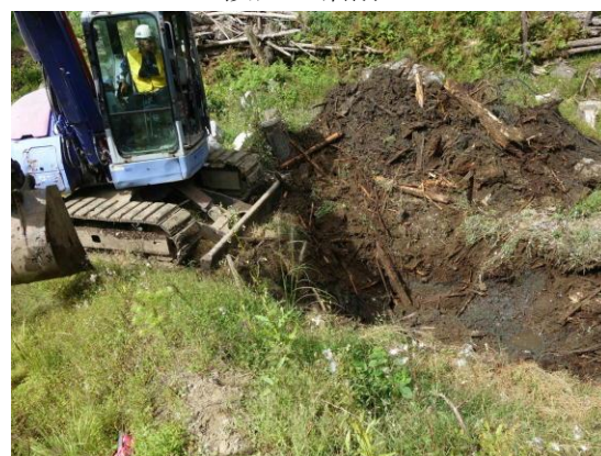
重機による埋設穴の掘削作業
