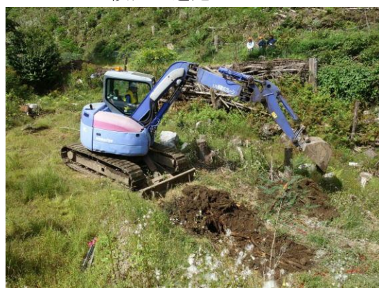
重機による埋設穴の掘削作業
