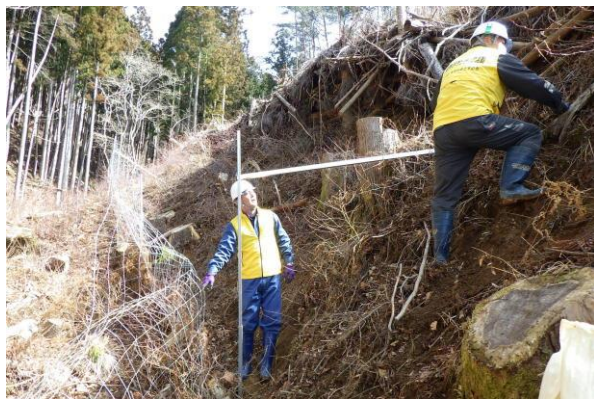
防鹿柵の撤去・取り替え作業状況
