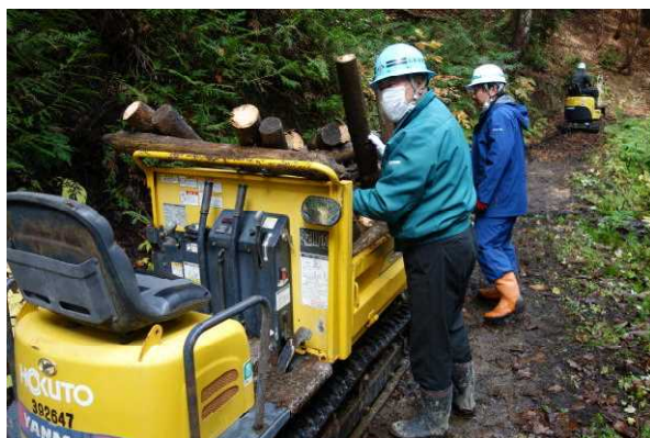
運搬車による搬出
