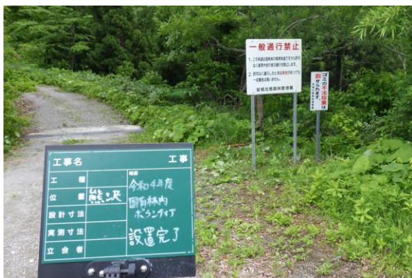
熊沢林道での設置状況
