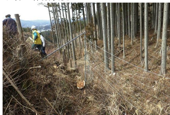
防鹿柵設置完了
