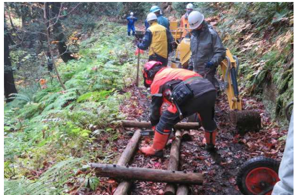
チェーンソーによる切断作業
