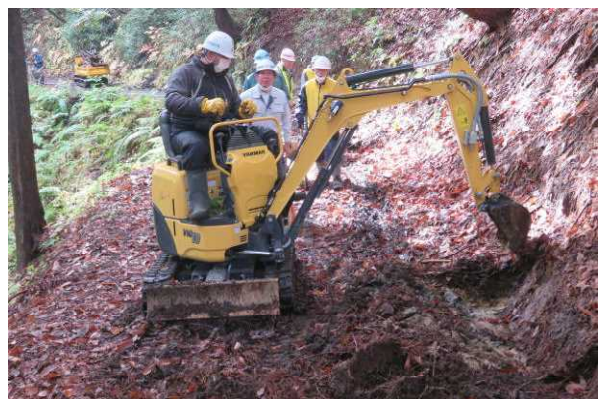
ミニバックホウによる掘削作業
