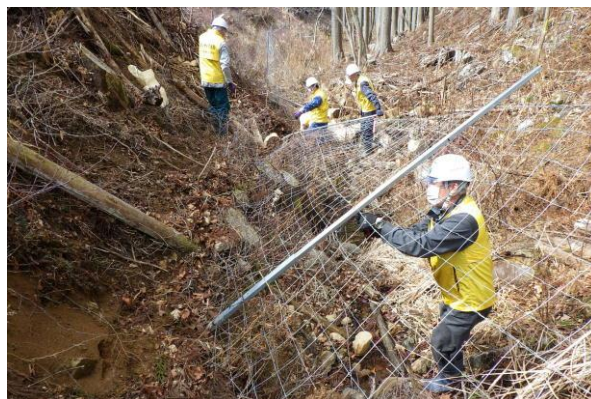
防鹿柵の撤去・取り替え作業状況
