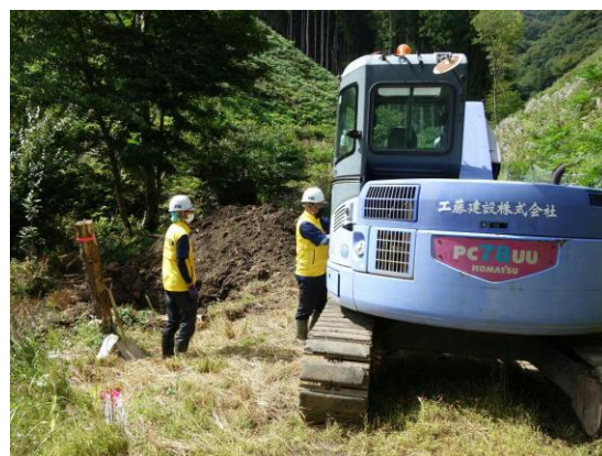
埋設穴の掘削
