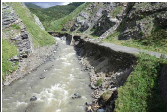
林道の洗掘状況（写真：金木支署提供）
