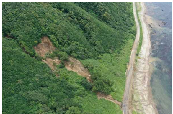
山腹の崩壊（写真：金木支署提供）
