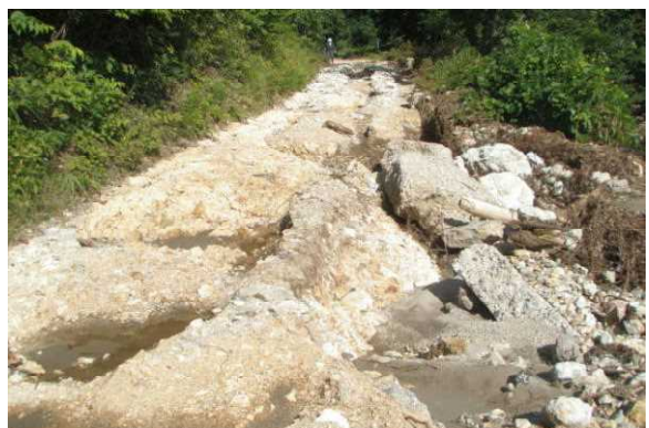
林道の洗掘状況（写真：金木支署提供）
