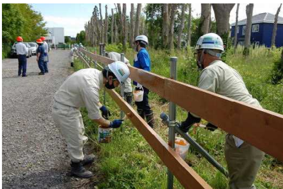
保護塗料の塗布作業
