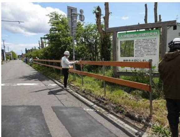
木製防護柵への保護塗料の塗布作業
