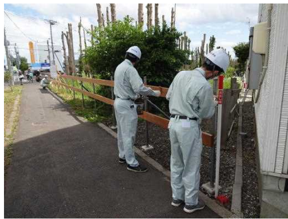
木製防護柵への保護塗料の塗布作業
