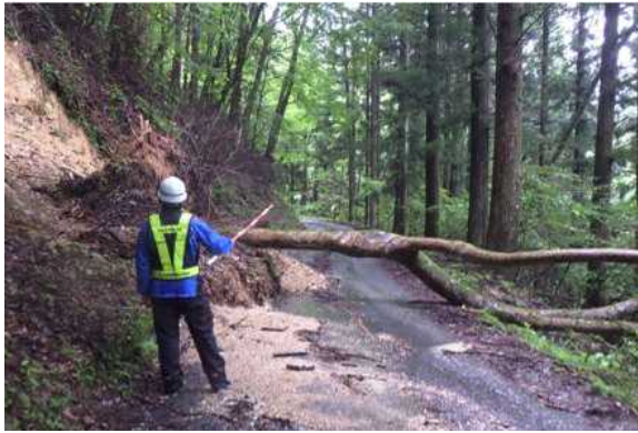
8月20日 林道法面の崩落
