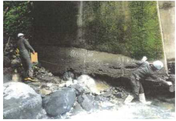
8月19日 橋台の洗堀状況調査
