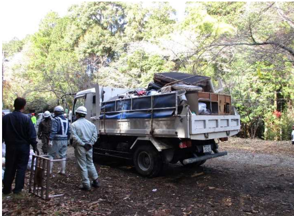
処分場に輸送する大量の廃棄物
