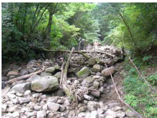
宮崎署 林道上部の崩壊
