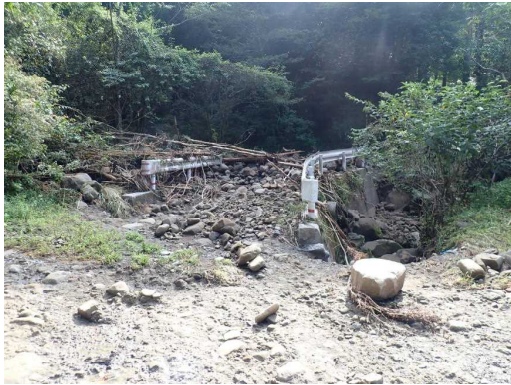
宮崎署 崩土による林道の閉塞
