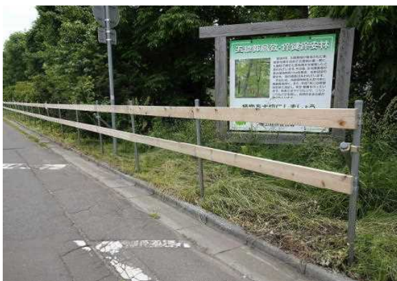
【木製防護柵】 塗料塗布前
