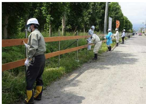
保護塗料の塗布作業
