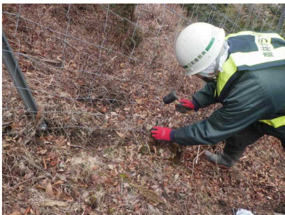
防鹿柵の補修（アンカーピンの打ち込み）
