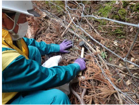
防鹿柵の補修（アンカーピンの打ち込み）
