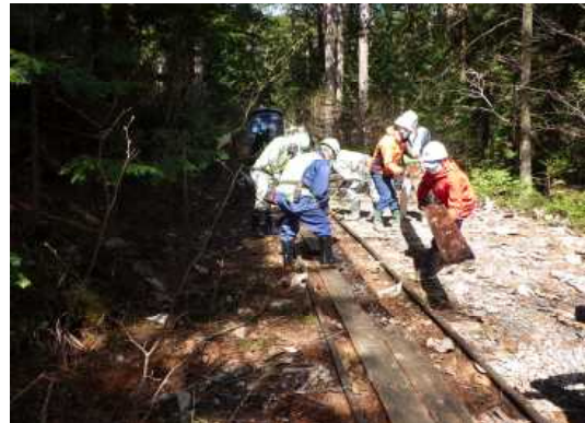
歩道の敷板の撤去作業
