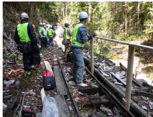
歩道の手すりの設置作業
