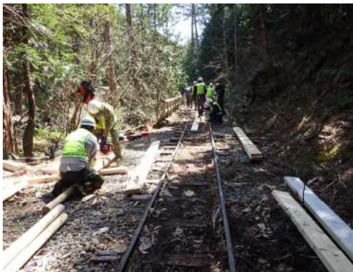
歩道の敷板の設置作業
