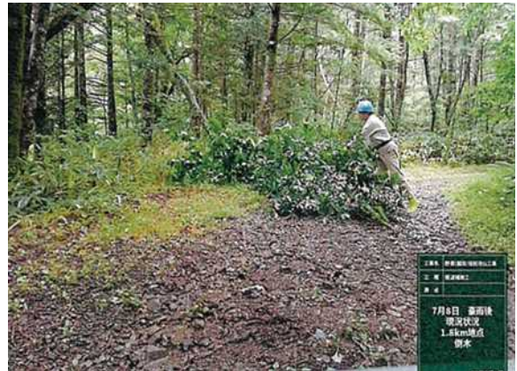
応急復旧(倒木の除去)
