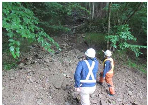
被災箇所の現地確認
