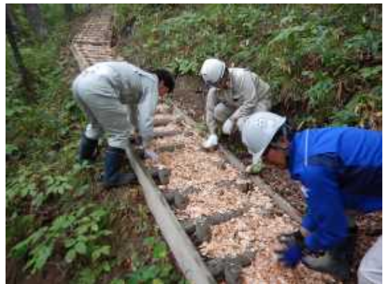
木製チップを遊歩道に敷均し
