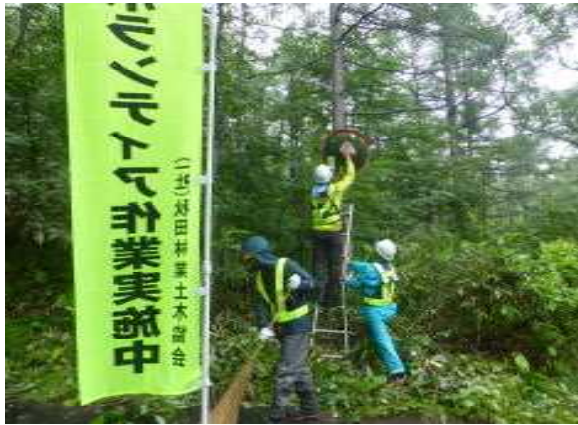
カーブミラーの清掃作業
