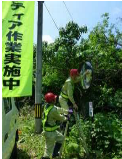
カーブミラーの清掃作業
