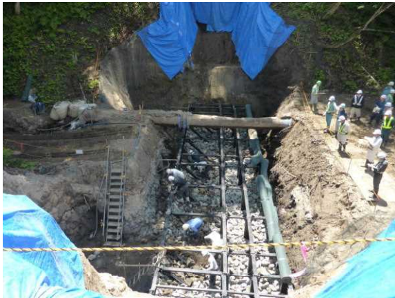
鋼製枠谷止施工箇所での安全点検
